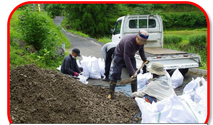
ボランティア活動家の急傾斜地崩落防止のために土のう作り
